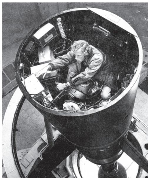
**Bild 21.7** Beobachterkabine im Primärfokus des 3,6-m-ESO-Teleskops. Foto: ESO
